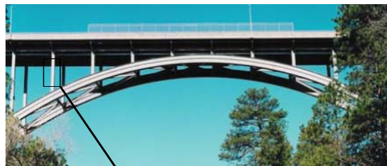
Canyon Bridge, Los Alamos, NM
